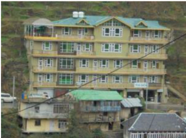
चिनाई के साथ आरसीसी भवन
